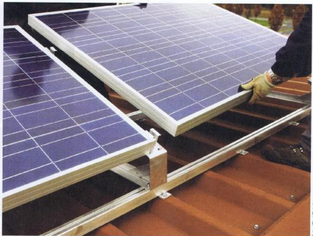
Eine Neigung der Solarmodule von rund 30 Grad ist optimal, auch eine Hinterlüftung steigert die Erträge.
