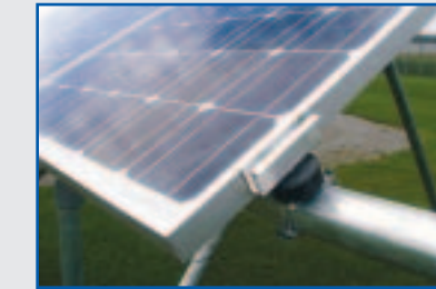
Modulhalterung mit Andruckplatte
